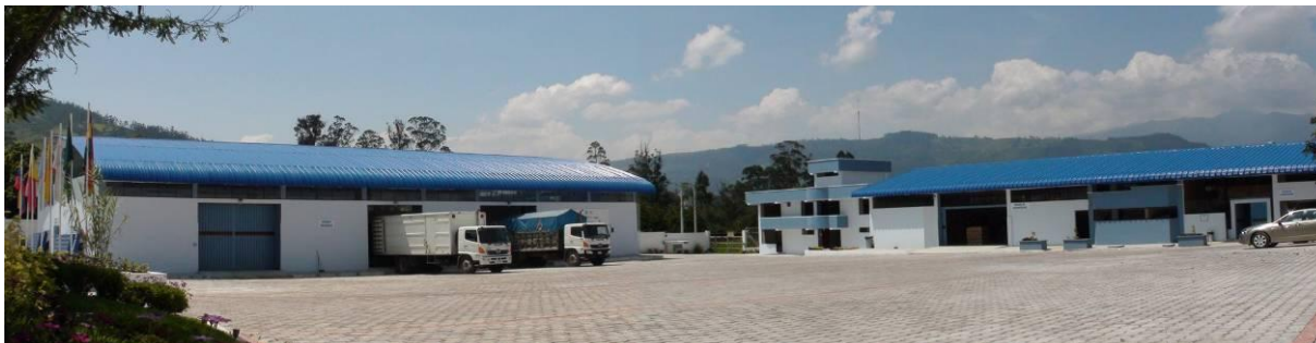
Vista del Centro Logístico de Asistencia Humanitaria, CELAH.
